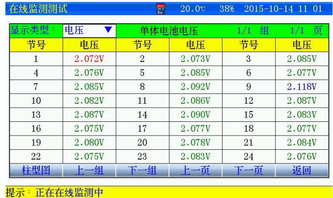
图 3.1.4 单体电压数据
